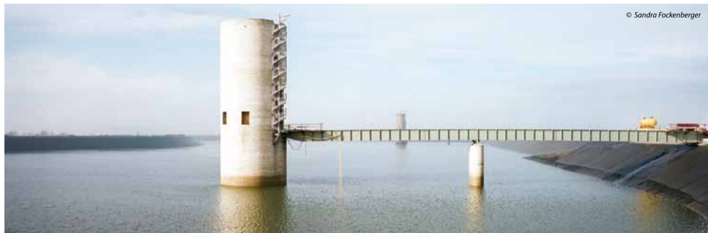
Le bassin supérieur avec la nouvelle tour de prise d'eau. La crête du barrage et la protection contre les vagues ont déjà été réalisés
